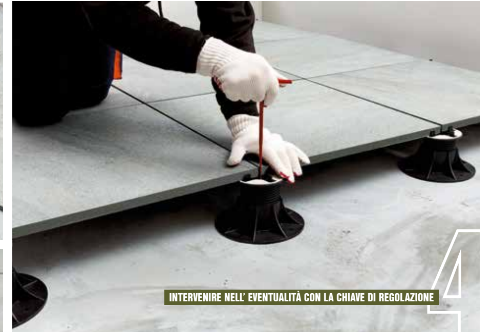
2 UTILIZZARE UN SUPPORTO AL CENTRO DELLA LASTRA (60X60 CM) PER UNA UNIFORME DISTRIBUZIONE DEL CARICO
