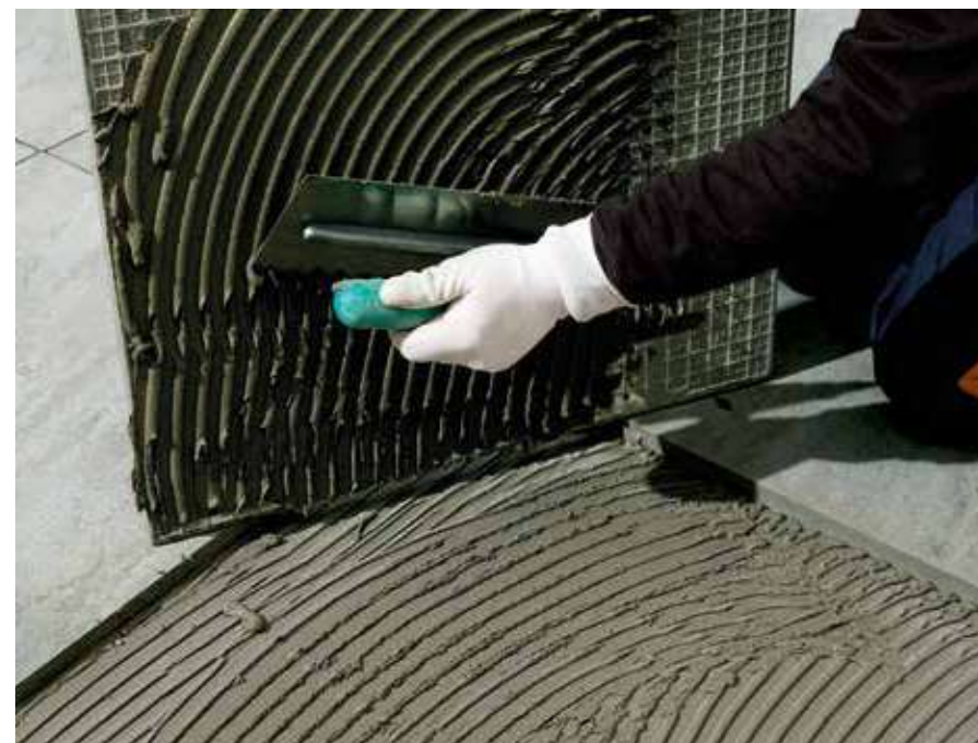
STENDERE L'ADESIVO IN MODO OMOGENEO SECONDO LA TECNICA DELLA DOPPIA SPALMATURA (SIA SUL FONDO CHE SUL RETRO DELLA PIASTRELLA)
